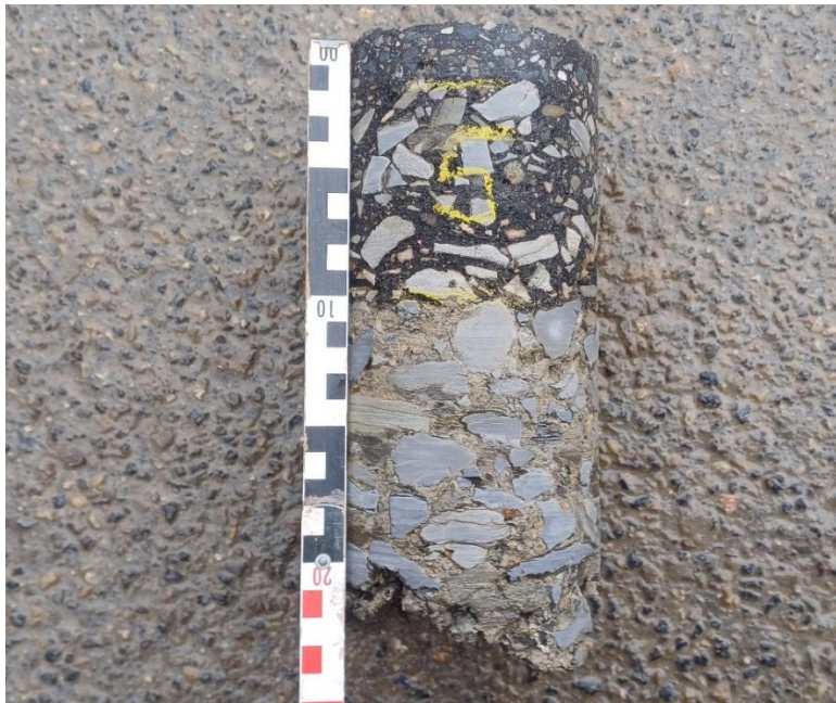
Abbildung 1: Bohrkern Asphalt KB 5
